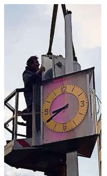
In luftiger Höhe wird der Zeitanzeiger in Position gebracht.
